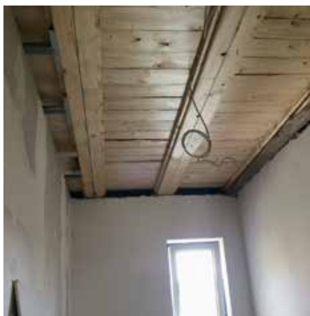
Nach der Sanierung: neue Holzbalkendecke ...
